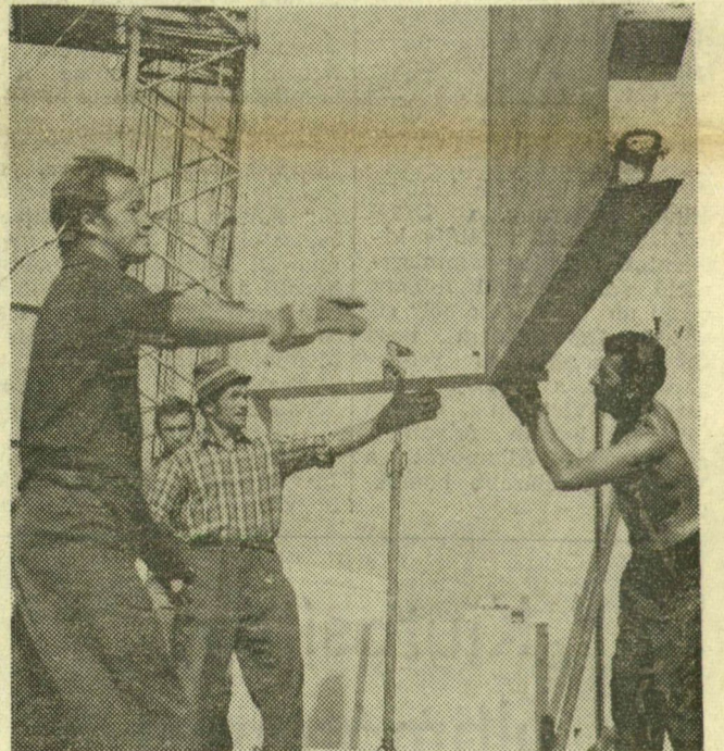
A paneleszerelők helyére illesztik az épület oldalfalait
